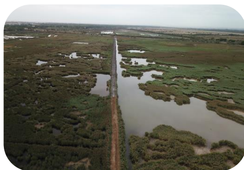
Vue aérienne des travaux 2021
