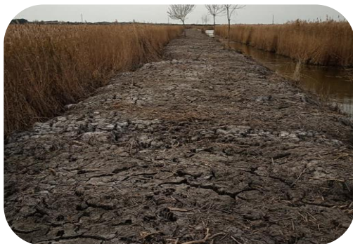
1 ère phase travaux + reconstitution du merlon en 2020
