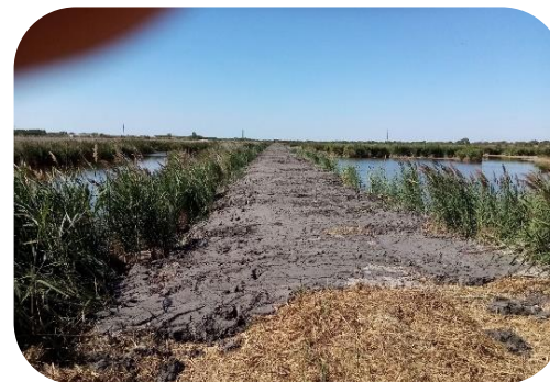
Début du tronçon de ~700 m en 2021
