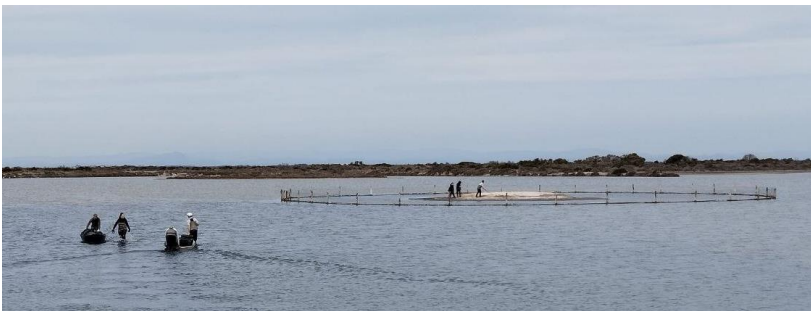
Figure 4 : Chantier îlot Salins d'Aigues-Mortes 25/03/2024 © Léa LAFOURNIERE - SMCG
